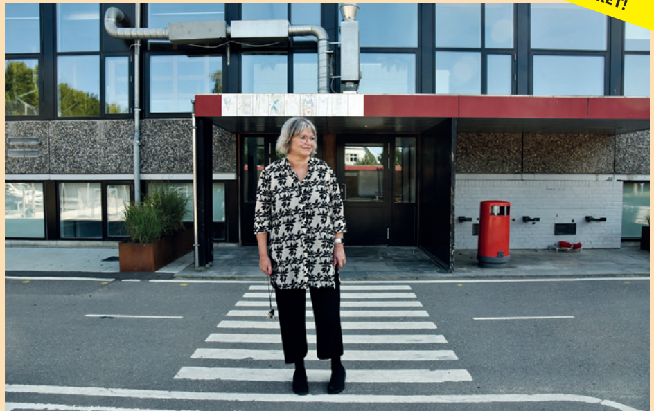
Skoleleder Berith Bonnesen foran den største og nyeste bygning på Næsby Skole, som nu betegnes som usikker. Bygningen var ellers næsten igennem en renovering, og skolen står til at modtage yderligere 18,5 mio. kr. fra byrådets pulje, "Velfærdens fundament"
